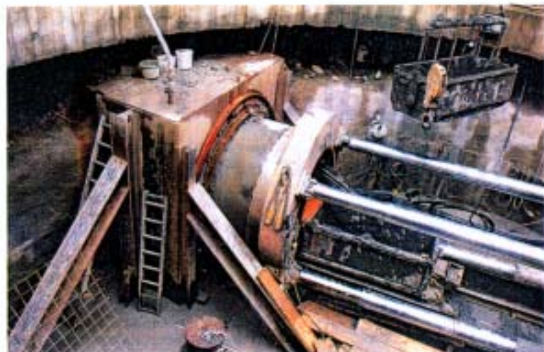
1 Das Teilprojekt Gelsenkirchen Schwarzbach setzt sich im Wesentlichen aus 2 Einzelbaumaßnahmen zusammen. Erstellt werden ein Sammler DN 1400 sowie ein Sammler DN 1600 bis DN 2000. Beide Kanäle werden im Rohrvortriebsverfahren ausgeführt
